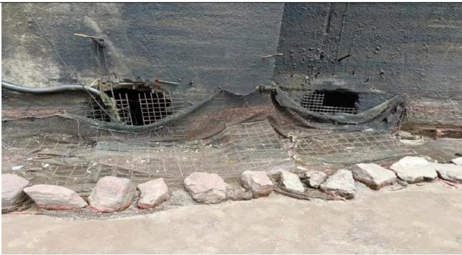
集污井（沉淀池）
