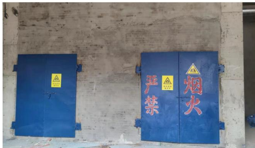
危险废物暂存间
