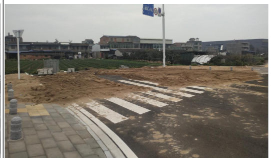
石壁路起点现状-道路
