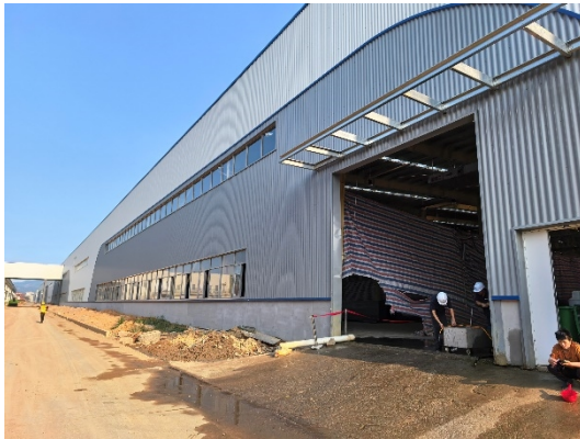
南侧钢化玻璃生产厂房
