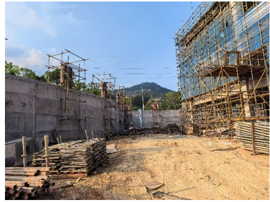
西侧已建挡墙及在建围墙（围墙为铁艺栅栏）
