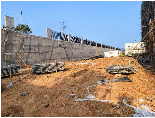
北侧已建挡墙及在建围墙（围墙为铁艺栅栏）
