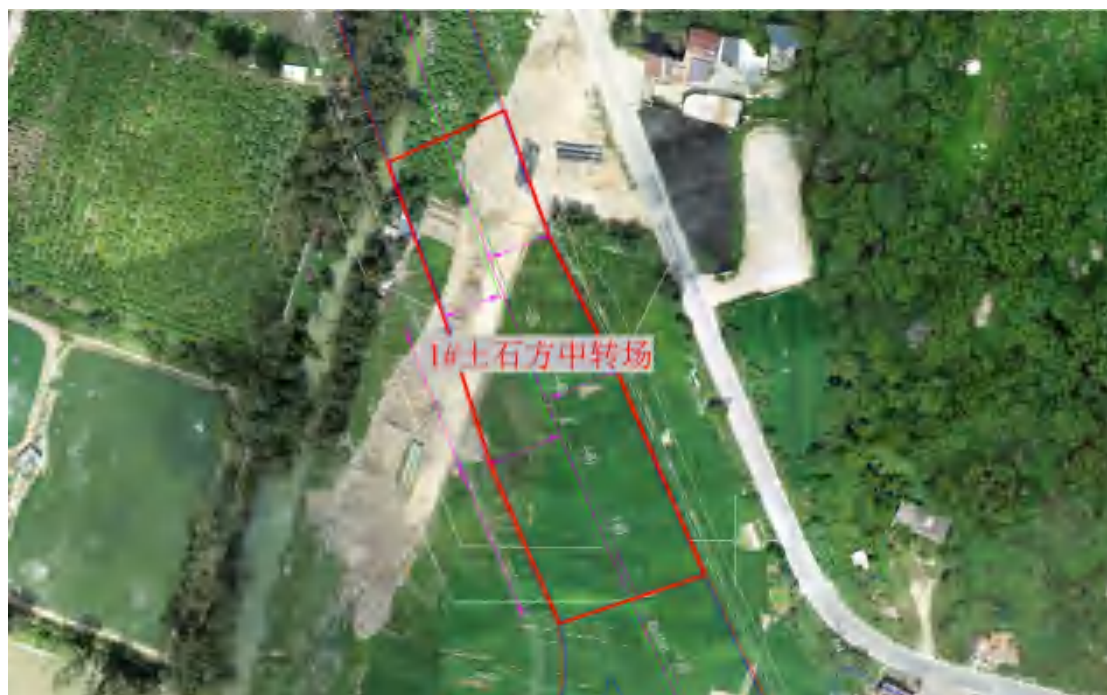
图 5.4-7 1#土石方中转场周边环境现状图
