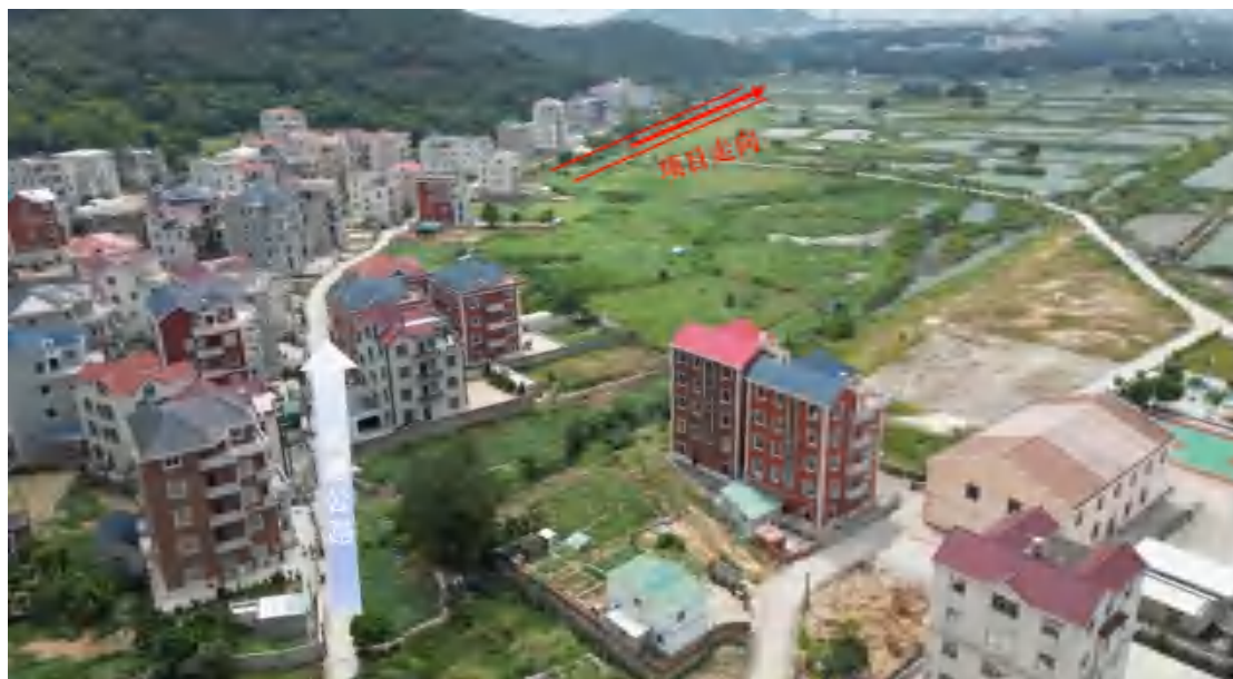
图 3.3-1 项目起点现状图
