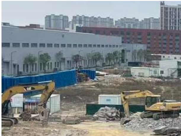
变电站南侧车间四（规划厂房）地块
