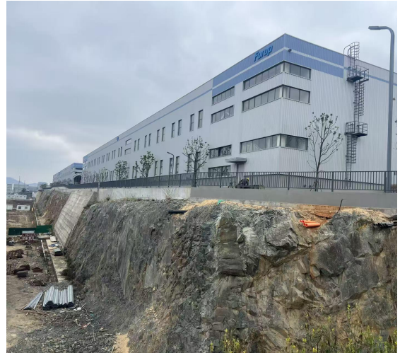
变电站西侧原料仓库三
