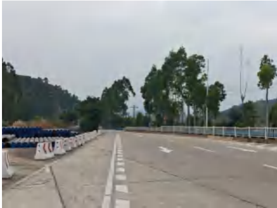
道路起点（通港大道官岭村）
