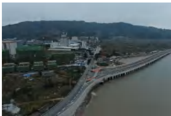
已建道路航拍
