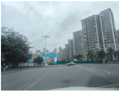
上洋片区安置房
