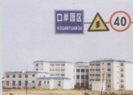
江阴港口岸园区
