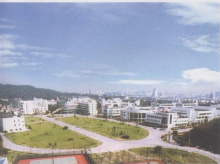
一期全景（俯视）
